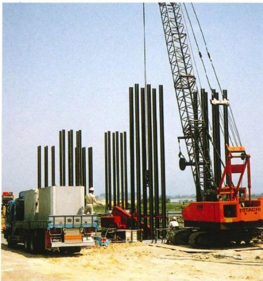
突起付きH型鋼の建込み状況
